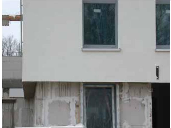
Die große Dämmstärke und die dünne Putzschicht sind maßgebend dafür, dass sich die Putzoberfläche stark abkühlt und unter die Lufttaupunkttemperatur fällt.
