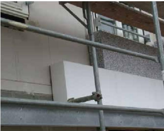
Dämmplatten mit Stärken von 20 cm und mehr zur Reduzierung der Transmissionswärmeverluste koppeln den Wärmestrom von innen nach außen ab.
