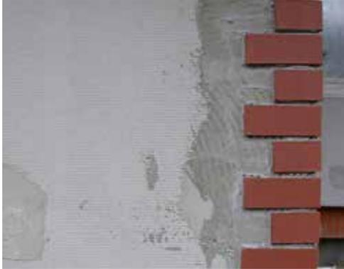
Wasseraufnahmefähigkeit kleiner 4,0 M.% können auch mit einem Schlämmörtel – in gleicher Weise wie Fliesen mit Schwamm Brett – verfugt werden, sofern die Oberfläche des Klinkerriemchens glatt ist.
