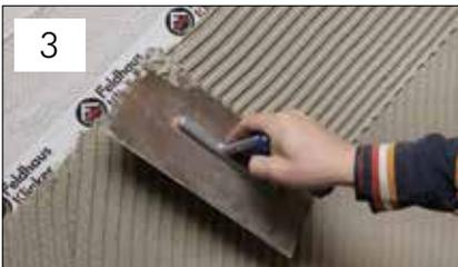
3 Für das Ansetzen von Klinkerriemchen ist ausschließlich das kombinierte Verfahren „Buttering-Floating“ nach DIN 12004 anzuwenden, bei dem sowohl auf den Untergrund als auch auf die Rückseite des Klinkerriemchens Kleber aufgetragen wird. (3) (4)
