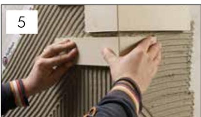
5 Klinkerriemchen mit einer Wasseraufnahmefähigkeit von  $\leq 4$  M.-% werden im herkömmlichen Verfahren für Ziegelfassaden mittels Fugeisen verfugt. Vorher muss der Verlegemörtel im noch plastischen Zustand flankensauber ausgekratzt werden. (7)
