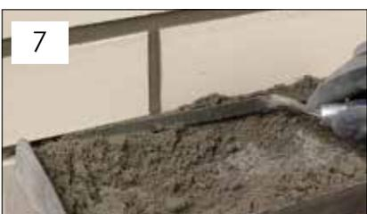
7 Da die Verfugung der Klinkerriemchen für die Optik der Gesamtfläche von großer Bedeutung ist, empfiehlt es sich, den Mörtel und die Verfugungsmethode zunächst an einer Musterfläche am selben Objekt zu testen.
