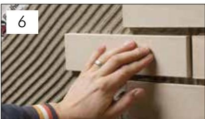
6 Klinkerriemchen mit einer Wasseraufnahmefähigkeit von  $\leq 4$  M.-% und einer glatter Oberfläche können auch mit einem Schlämmörtel – in gleicher Weise wie Fliesen mit einem Schwammbrett – verfugt werden.
