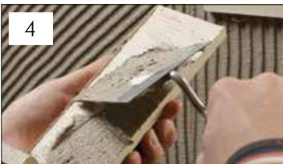
4 Zunächst Winkelriemchen an den Außenecken ansetzen, anschließend die Riemchen verlegen. (5) (6)
