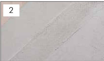
2 Dadurch soll ein homogener und gleichmäßiger Untergrund mit wasserabweisenden Eigenschaften vorbereitet werden. Der Unterputz muss vor dem Ansetzen der Riemchen aushärten und seine Oberflächenspannungen abbauen. (2)
