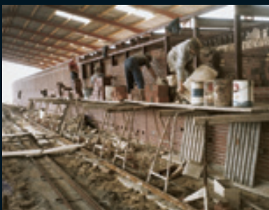
Bau des Tunnelofens Tunnel kiln construction
