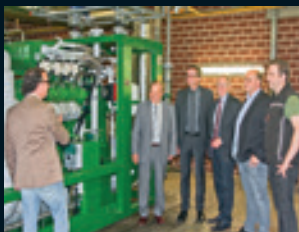
Inbetriebnahme des Blockheizkraftwerks Initial operation of a block heating and generating plant
