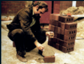
Grundsteinlegung des Schornsteins Laying of the chimney foundation stone
