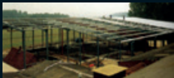
Eindeckarbeiten Tonlagerhalle Roofing works carried out on the clay storage hall
