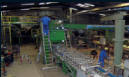
Die neue Pressenlinie für Riemchen und Winkelriemchen wird installiert New pressing line for brick slips and corners installed
