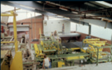
Installation der Setzanlage Setting machine installed
