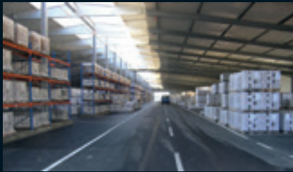
Lagerhalle für die Logistik von Klinkerriemchen mit Platz für 11.500 Paletten Warehouse and logistics for brick slips providing space for 11,500 pallets
