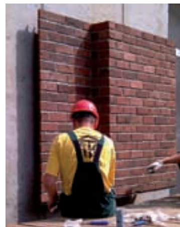
Монтаж навесной вентсистемы «ДИАТ»
