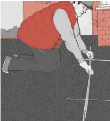
17. Das Abziehen der Bettung kann nun erfolgen. Hierfür werden die Abziehlehren in der vorgesehenen Höhe und dem entsprechenden Gefälle eingemessen.
