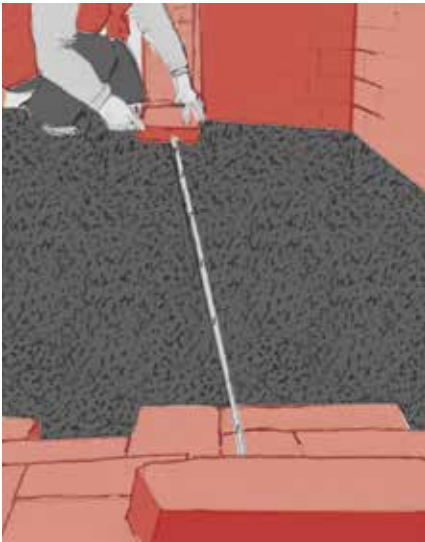
20. Eine Richtschnur wird je nach Verlegeverband abschnittsweise gezogen, um die Fugenfucht, Fugendicke und den Verband der verlegten Pflasterfläche zu bewahren.
